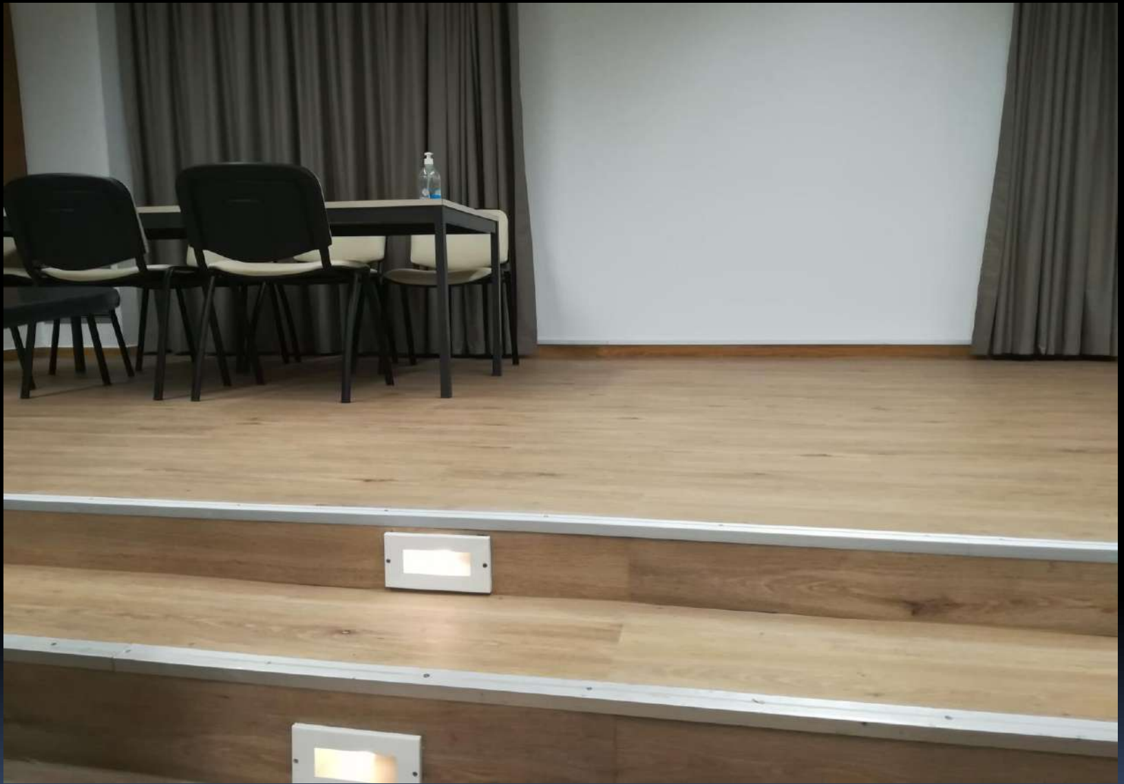
Επιδιόρθωση – ανακαίνιση του επιδαπέδιου φωτισμού.
