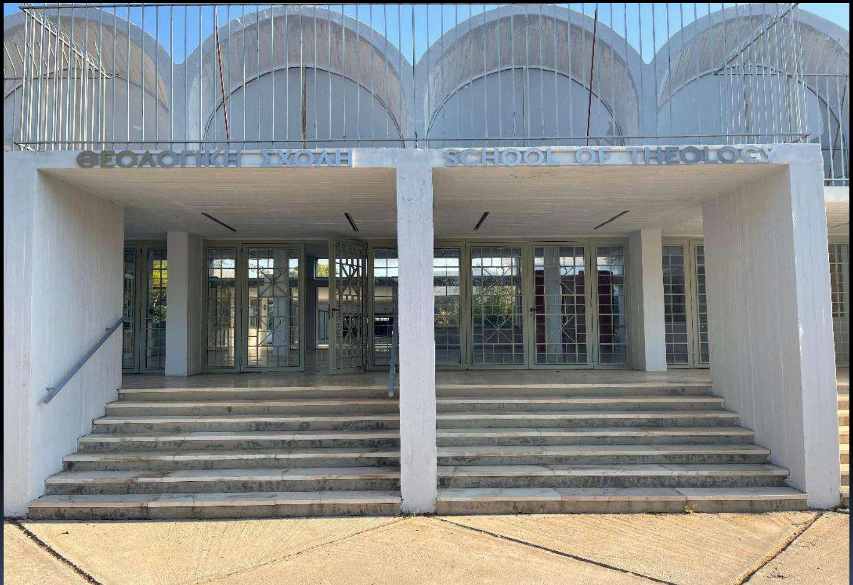
Τοποθέτηση νέας πινακίδας στην άνω είσοδο της Σχολής.
