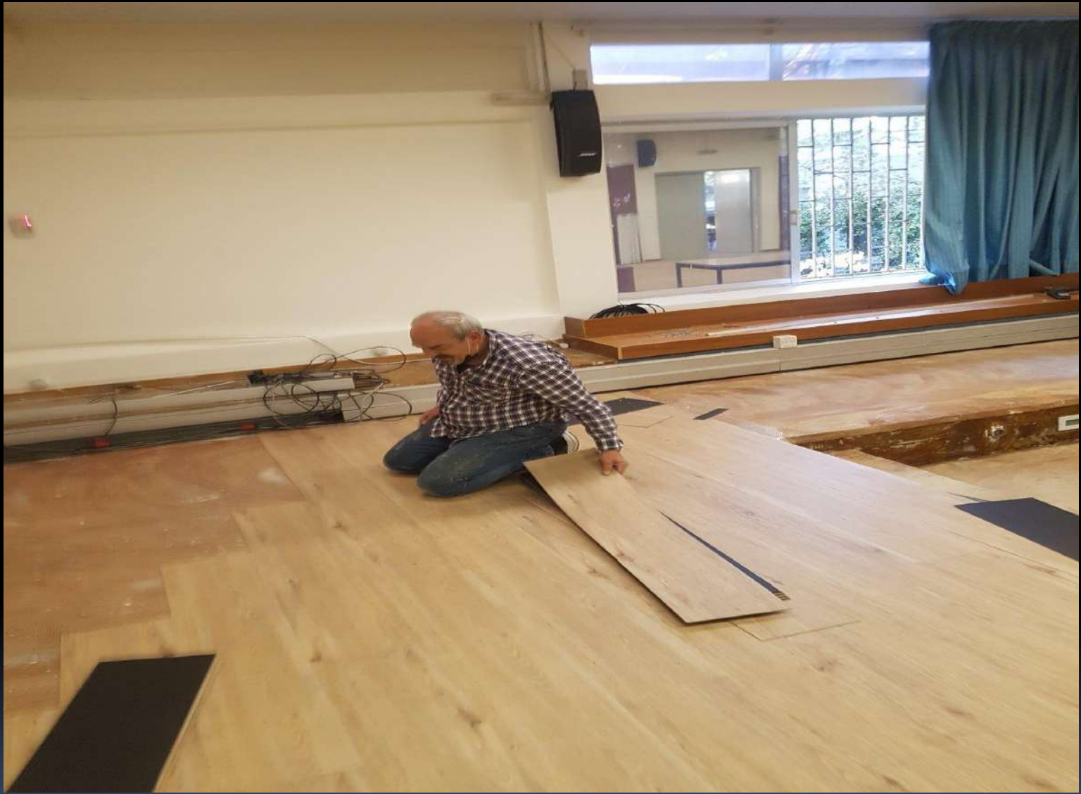
Τοποθέτηση νέου δαπέδου.
