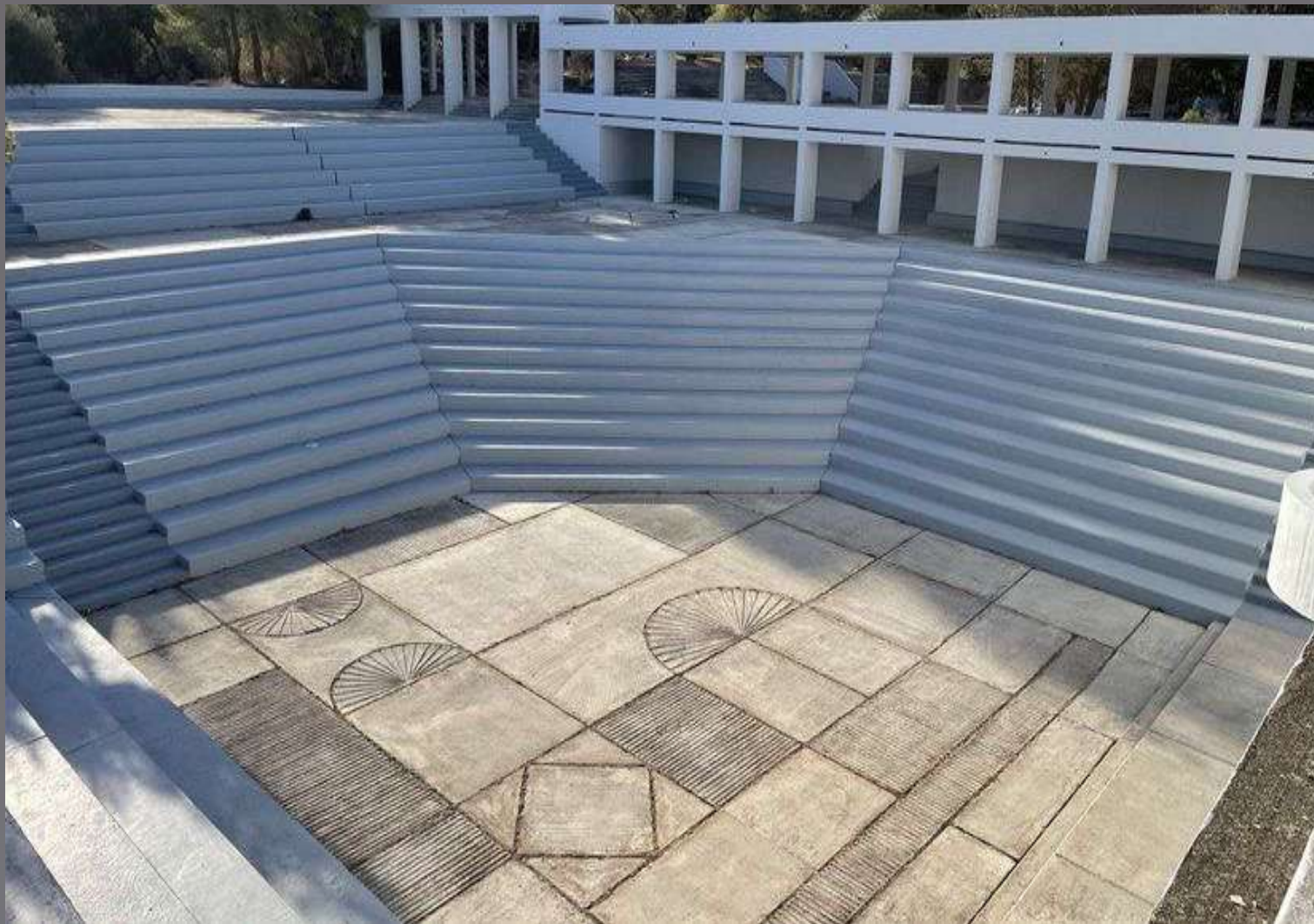
Το υπαίθριο αμφιθέατρο μετά την ανακαίνιση.
