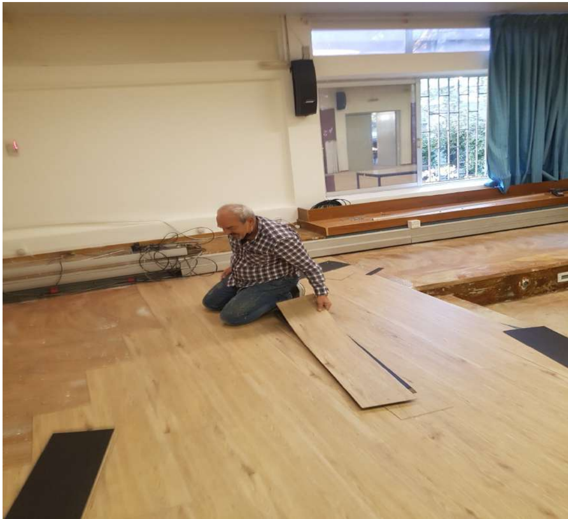
Τοποθέτηση του ξύλινου δαπέδου.
