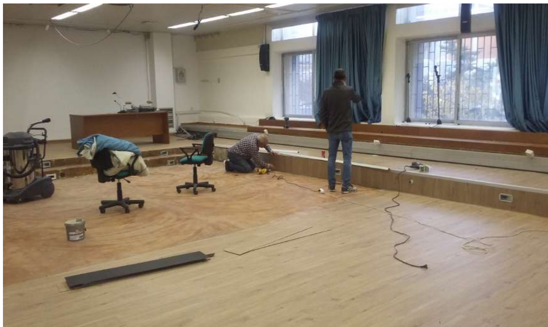
Από την τοποθέτηση του ξύλινου δαπέδου.
