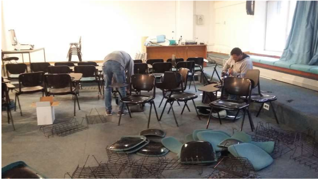
Επιδιόρθωση των καθισμάτων.
