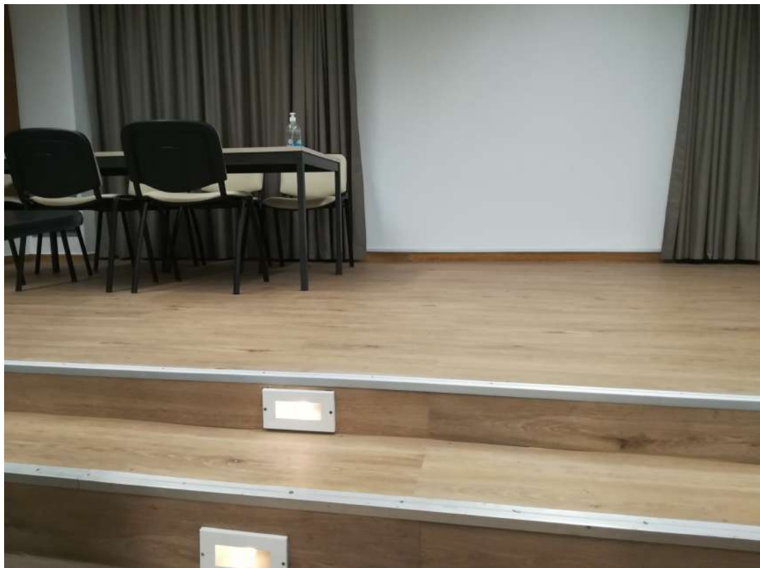
Επιδιόρθωση – ανακαίνιση του επιδαπέδιου φωτισμού.
