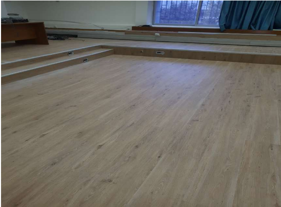
Ολοκλήρωση του ξύλινου δαπέδου.
