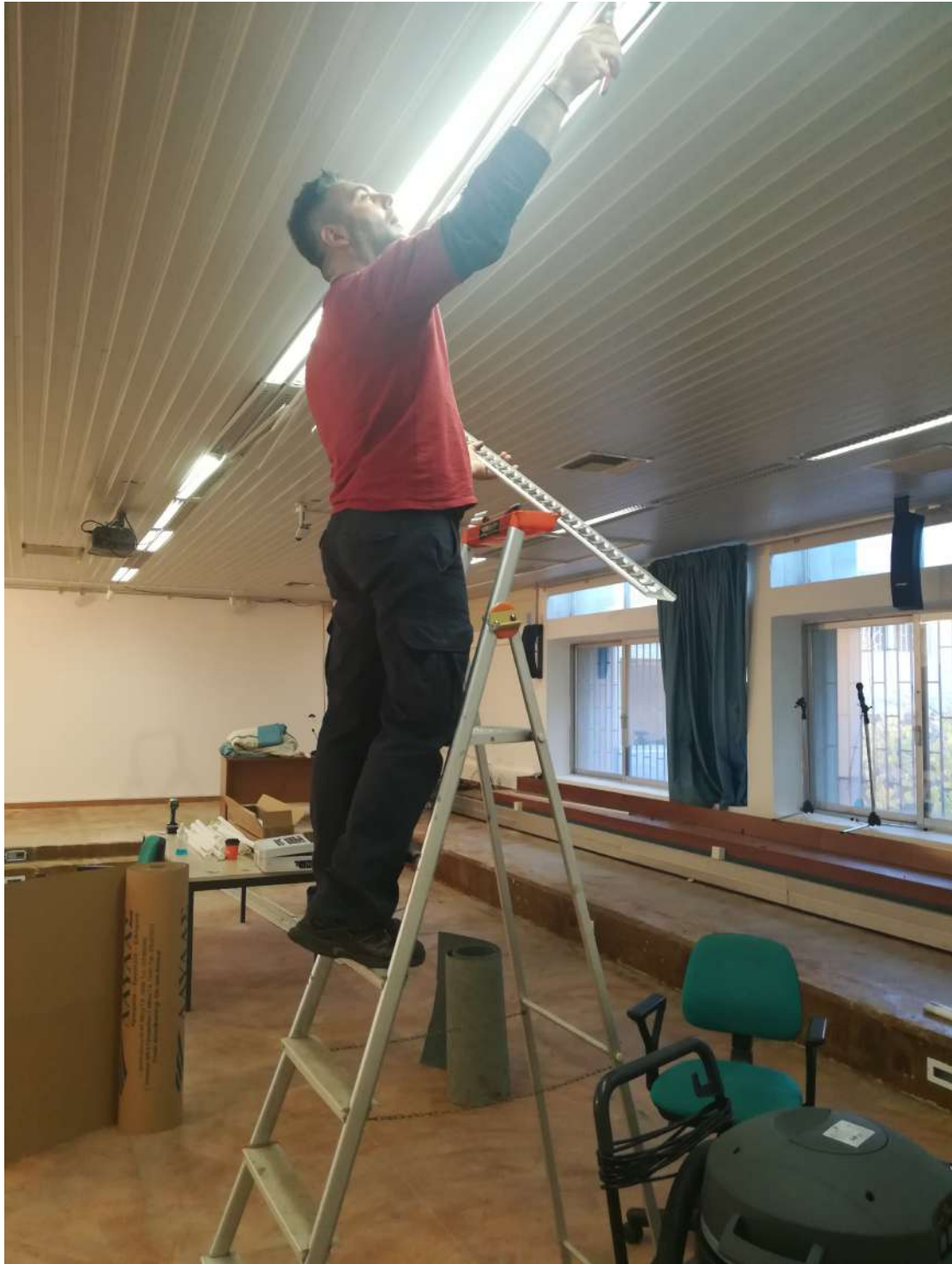
Αντικατάσταση των καλωδιώσεων και των λαμπτήρων.
